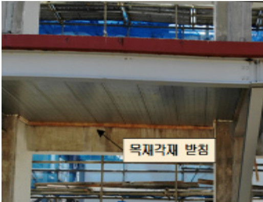
[그림 51. 붕괴된 데크플레이트 및 데크플레이트 받침 설치 모습]
