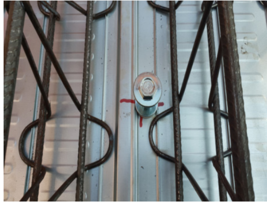
데크플레이트에 위치 표기 후 설치
