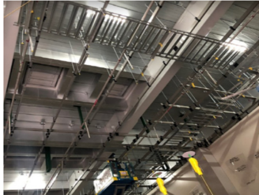
세트앵커볼트와 전산볼트 연결
