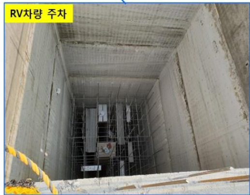
[그림 45. 주차타워 내부 비계설치 상태]
