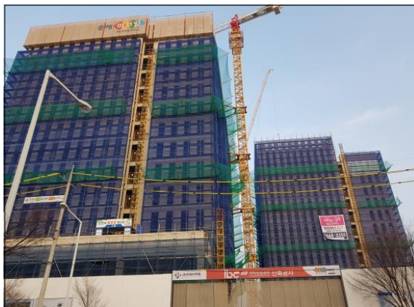
[그림 43. 사고발생 좌측 동 및 타워크레인 설치 모습]
