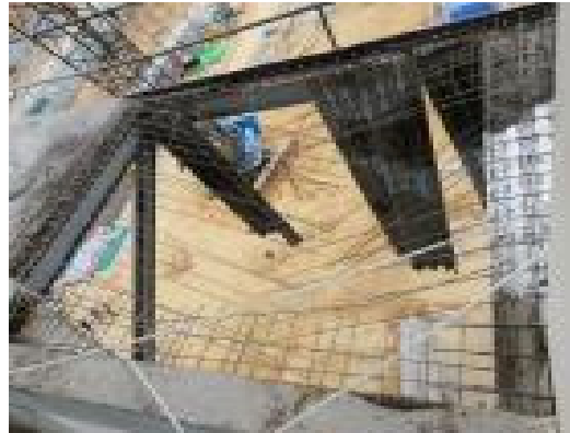
[그림 51. 붕괴된 데크플레이트 및 데크플레이트 받침 설치 모습]
